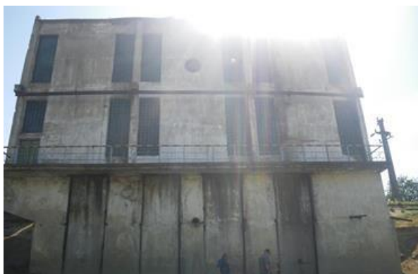
Figura 4.21. Fațadă posterioară Clădire stație pompare (2017) Figure 4.21. Rear facade Pumping station building (2017)
