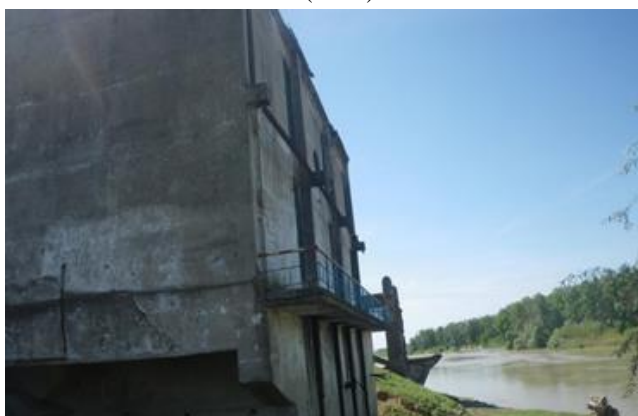
Figura 4.20. Fațadă laterală dreapta Cladire stație pompare (2017) Figure 4.20. Right side facade Pumping station building (2017)
