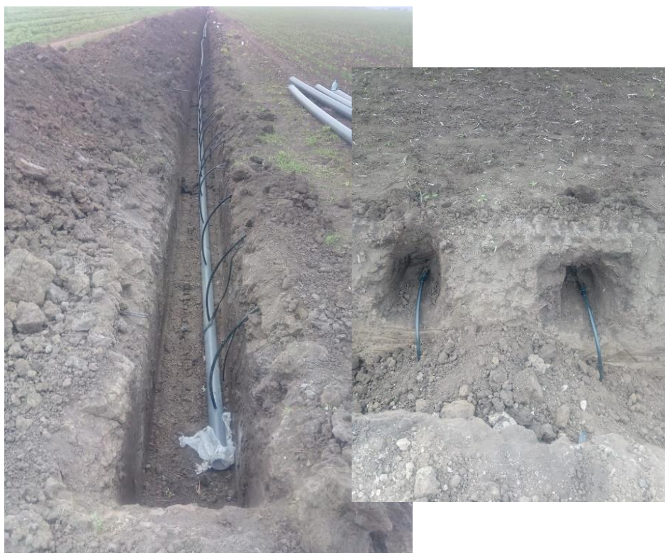
Figura 4.9. Conducte de udare prin picurare amplasate sub suprafața terenului (SC Triticum SRL)
