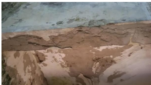
Figura 4.18. Planșeu și pereți Stație de pompare (2017) Figure 4.18. Floor and walls Pump station (2017)
