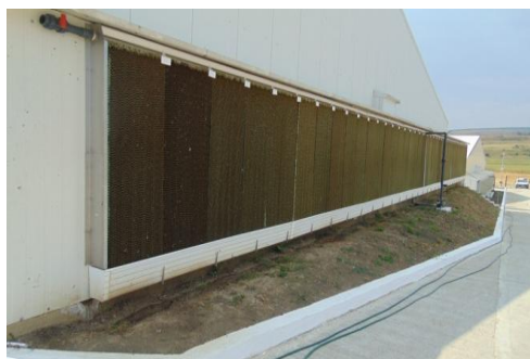
Fig. 6.8 Ferma Mărășești-sistemul de condiționare a aerului (foto original) a-admisii aer; b-instalație de răcire pad-cooling Fig. 6.8 Mărășești farm-air conditioning system a-air admissions; b- pad-cooling installation
