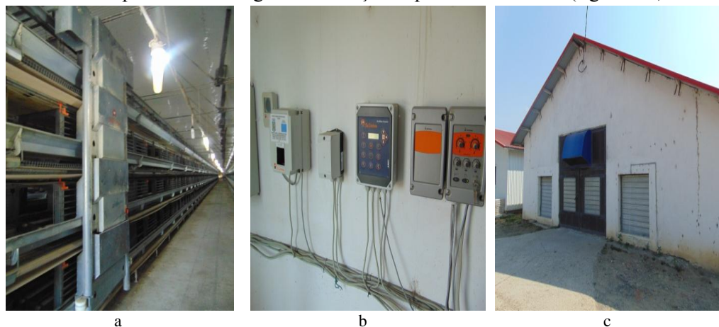
Fig. 6.5 Ferma Bogești-echipamente de hală (foto original) a-echipament de furajare; b-computer de hală; c-echipament de ventilație
