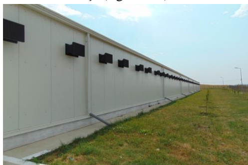
Fig. 6.8 Ferma Mărășești-sistemul de condiționare a aerului (foto original) a-admisii aer; b-instalație de răcire pad-cooling Fig. 6.8 Mărășești farm-air conditioning system a-air admissions; b- pad-cooling installation
